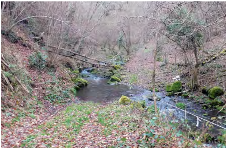
Aménagement sur le Dolaizon
