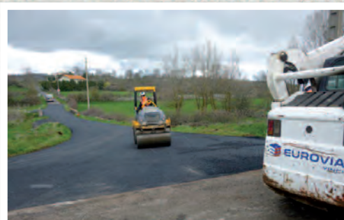
Goudronnage Pont de Jabier
