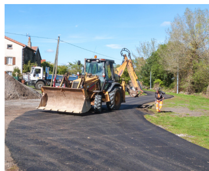
« L'aménagement des bas côtés à Espale suite à la réfection de la chaussée.
