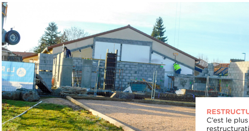
Les travaux en cours de reconstruction de l'espace Jacques Brel.
